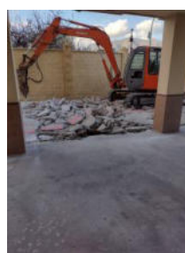
Derivo plancho de hormigón antiguo, instalación de mallazo vertido de hormigón y fratasado. Edf Salinas, Los Boliches. Enero 2022.
