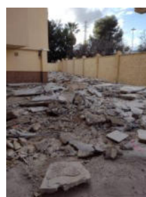
Derivo plancho de hormigón antiguo, instalación de mallazo vertido de hormigón y fratasado. Edf Salinas, Los Boliches. Enero 2022.
